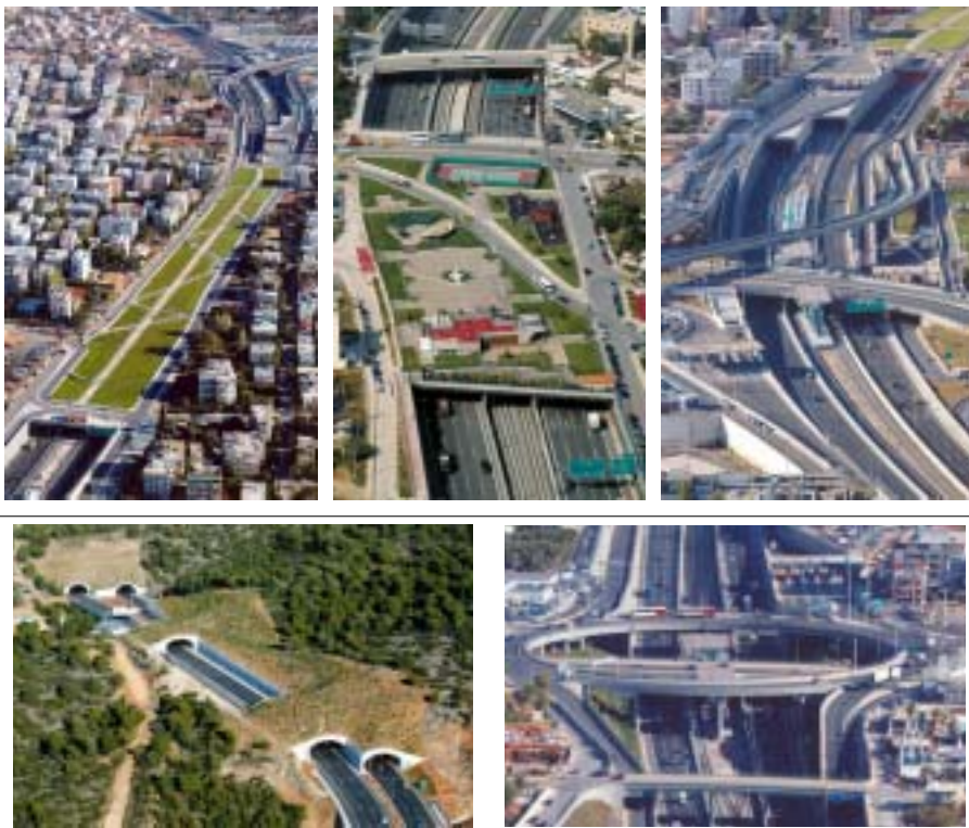
<그림 3-2> 그리스 Attica Tollway
