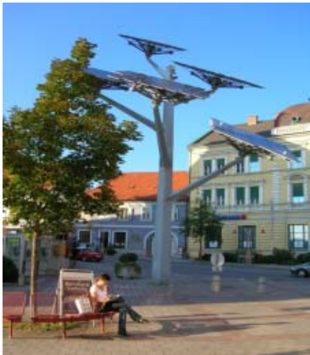
<그림 5-4> 도로 유휴지에 사용가능한 태양에너지 생산시설
