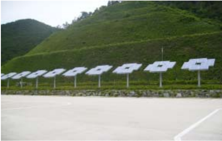
<그림 5-6> 고창휴게소에 설치된 태양 집전시설
